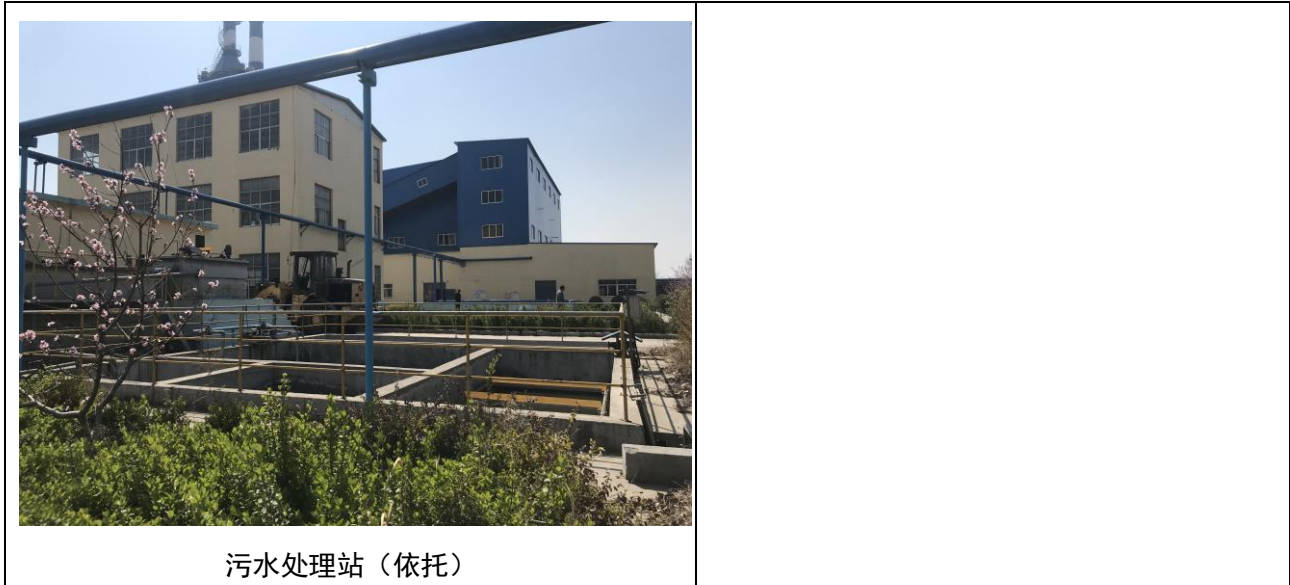
图 3-1 本项目主要生产装置及环保设施现状图
